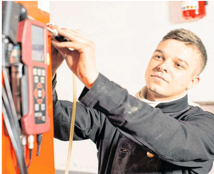
Die normalen Prüfarbeiten an der Heizungsanlage finden regelmäßig statt und können von jedem frei wählbaren Schornsteinfeger erledigt werden – im Gegensatz zur sogenannten Feuerstättenschau. BILD: BUNDESVERBAND DES SCHORNSTEINFEGERHANDWERKS
